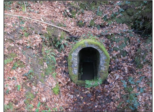
Source aménagée à flanc de talus
